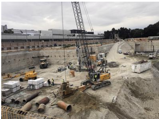
Die Tiefbrunnen für die Wasserhaltung wurden mittels Großlochbohrung hergestellt. Quelle: PORR
