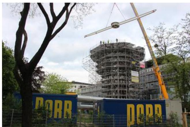
Einhub des 28m langen Plattformträgers mit zentraler Ringkonstruktion. (c) PORR
