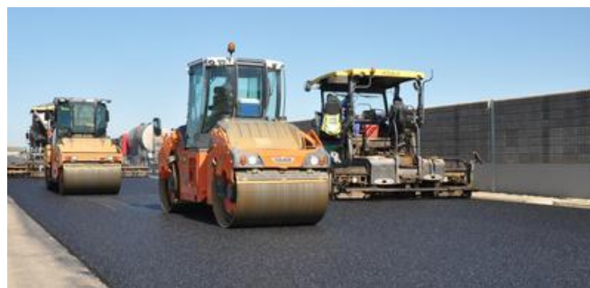
Arbeiten auf Hochdruck: Asphaltarbeiten an der neuen Autobahn. Bild: PORR AG
