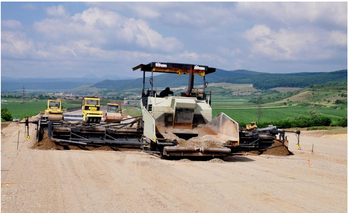
Einbau der hydraulisch gebundenen Tragschichten mittels Fertiger. Bild: PORR AG
