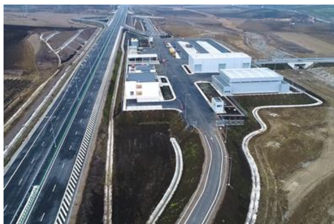
Das Straßenerhaltungszentrum direkt neben der Autobahn. Bild: Pro Infrastructure
