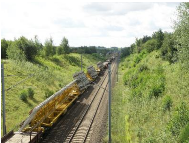
Transport der Weichenblocks. Bild: PORR AG
