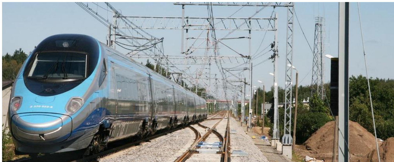
Zugdurchfahrt über den erneuerten Oberbau der Überleitstelle Biała Rawska. Bild: PORR AG
