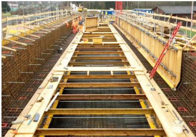
900 m 3 Konstruktionsbeton waren für die Errichtung einer Etappe der Bahnbrücke nötig. Bild: PORR AG
