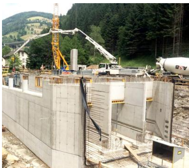
Betonarbeiten bei dem aus drei Kammern bestehenden Entsander. Bild: PORR AG
