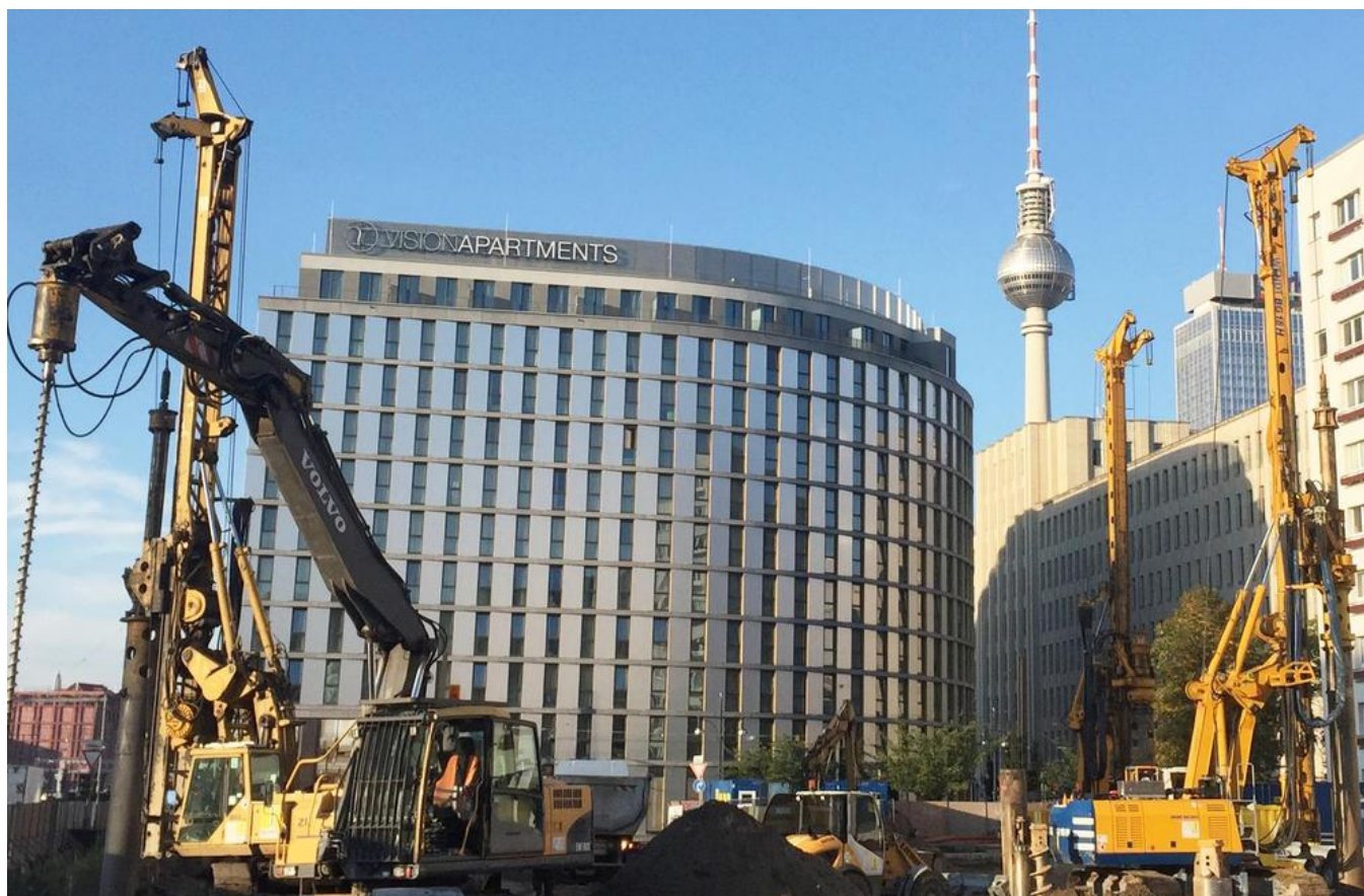
Großbohrgeräte bei der Erstellung von Bohrspfählen. Bild: PORR AG
