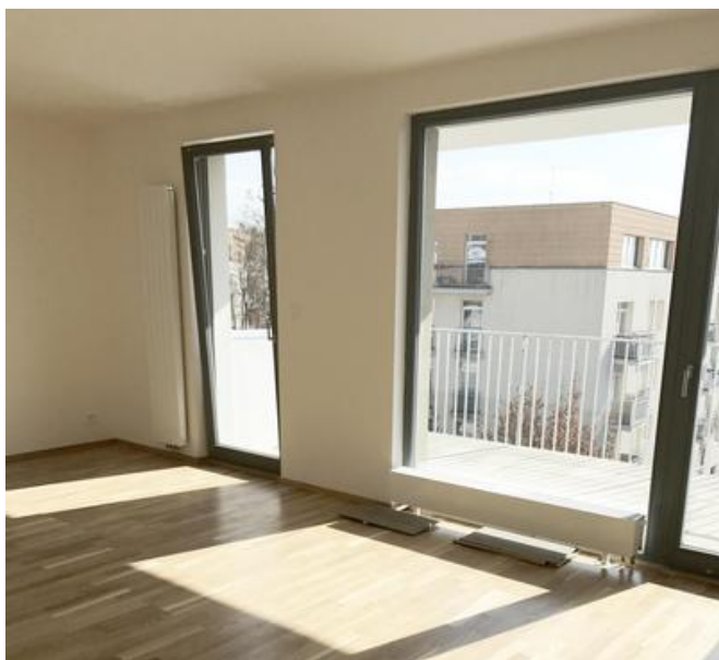
Wohnzimmer mit schwimmendem Fertigparkett aus Holz und Holzfenstern. Bild: PORR AG
