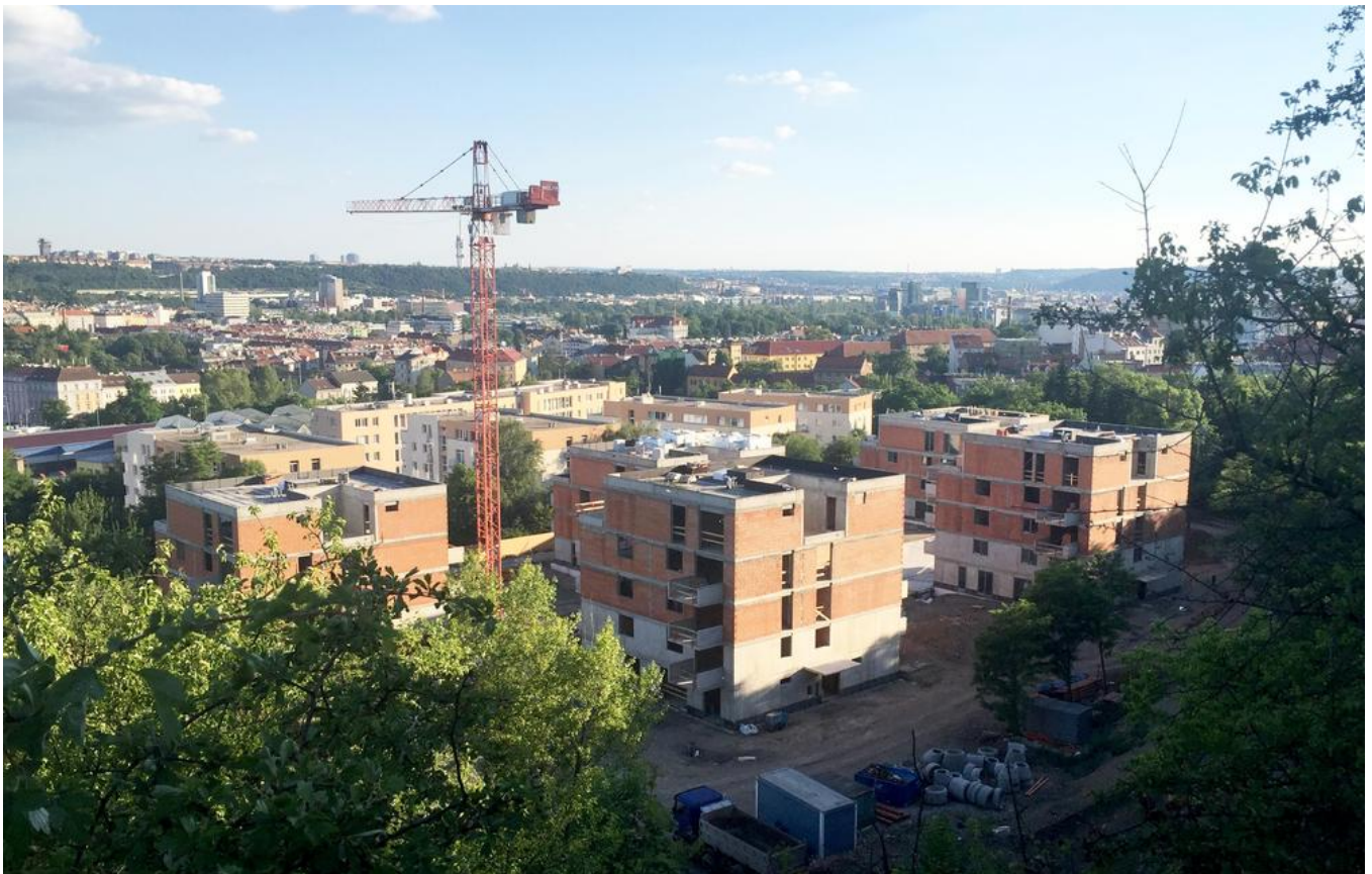
Die neue Wohnanlage im Rohbau. Bild: PORR AG
