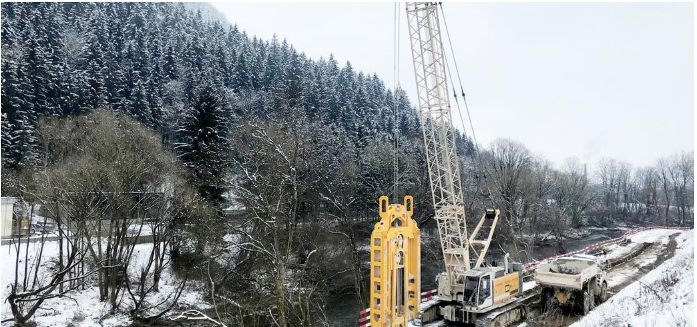
Herstellung der Schlitzwand. Bild: PORR Bau GmbH
