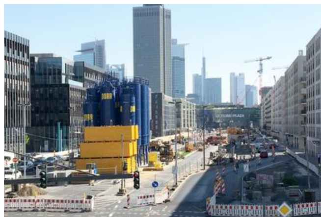
Baustelleneinrichtung und Fahrstreifenreduzierung auf der Europa-Allee. Bild: PORR AG
