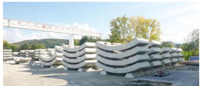
Die Tübbinge werden per Bahn in ein Zwischenlager in Frankfurt geliefert. Bild: PORR AG
