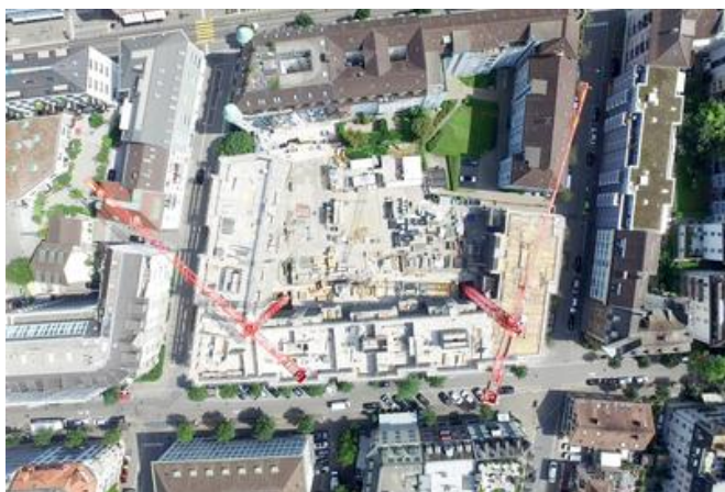
Die Baustelle aus der Vogelperspektive. Bild: PORR AG
