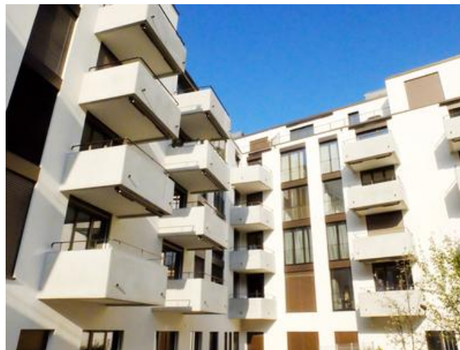
Das Projekt wurde nach dem Schweizer Minergie-Standard errichtet und verfügt damit über eine höhere Energieeffizienz als gesetzlich gefordert. Bild: PORR AG
