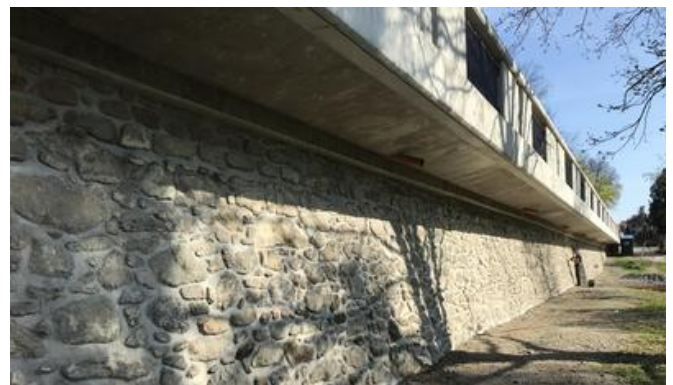
Das Fundament der Brücke besteht aus Natursteinen. Quelle: PORR
