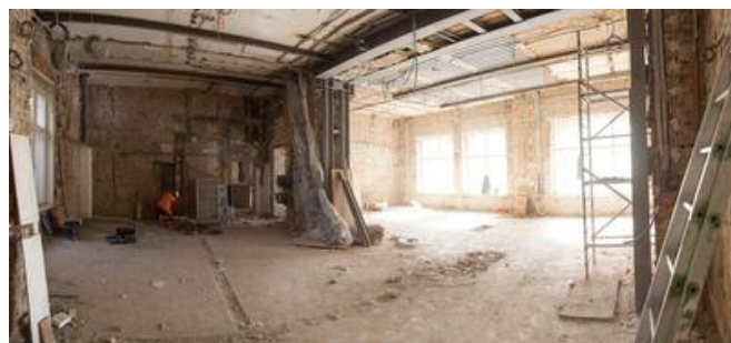
...und während der Umbauarbeiten Quelle: PORR
