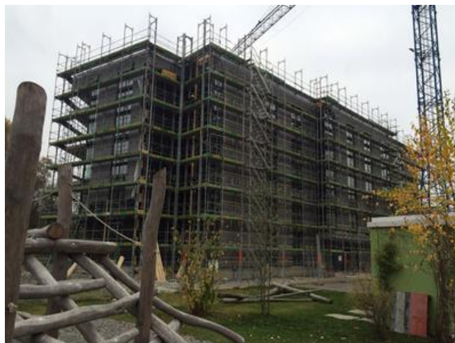
Der Rohbau vor Montage der hinterlüfteten Fassade. Quelle: PORR AG
