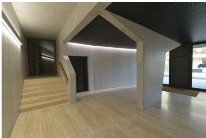
Die fertige Eingangshalle mit der markanten Betonstütze: Mittels Rückbiegeanschluss war ein unsichtbarer Anschluss der Decke möglich. Quelle: PORR AG
