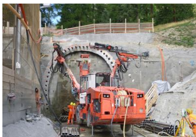
In Spinas erfolgte der Rohrschirmvortrieb bei laufendem Bahnbetrieb. Quelle: PORR
