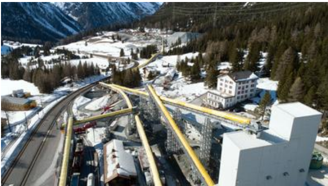
In Preda betreibt die ARGE ein Kieswerk, in dem wöchentlich bis zu 4.000 t Ausbruchmaterial aufbereitet werden können. Quelle: Torsten Schaarschmidt, Pöyry Schweiz AG
