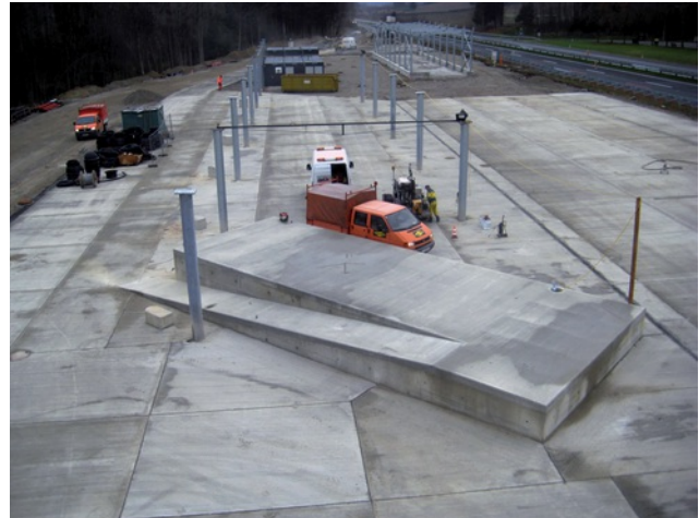
Baufeld Bild: PORR
