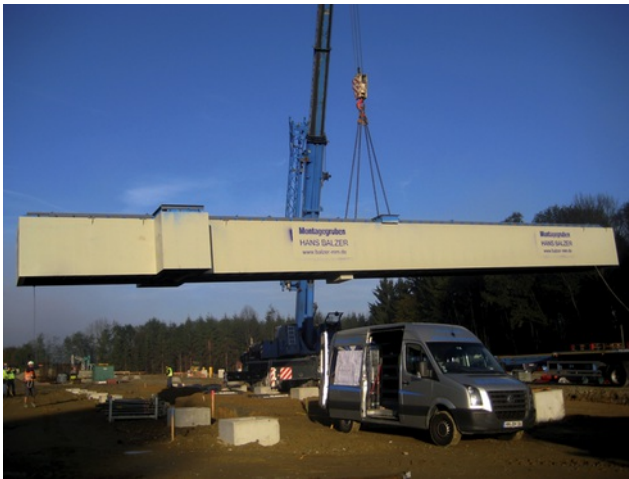
Versetzen Prüfgrube Bild: PORR
