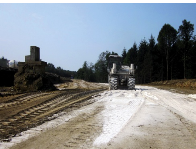
Bodenverbesserung Bild: PORR
