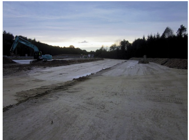
Bodenverbesserung Bild: PORR
