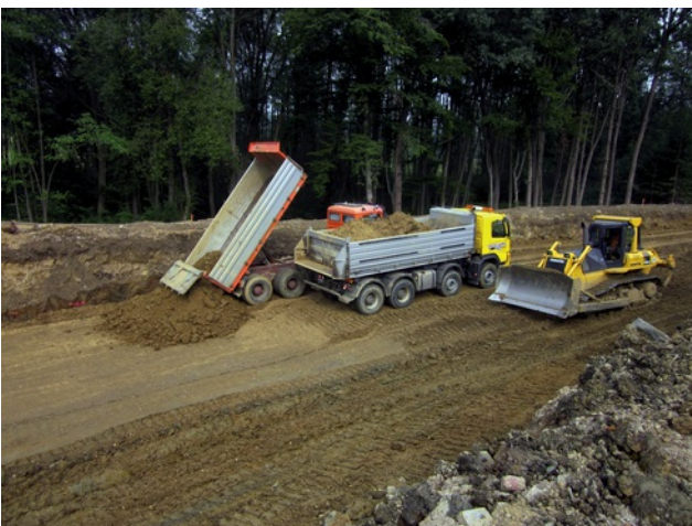
Bodenverbesserung Bild: PORR
