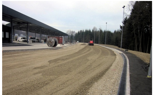
Ungebundene obere Tragschicht mit Flugdach Bild: PORR
