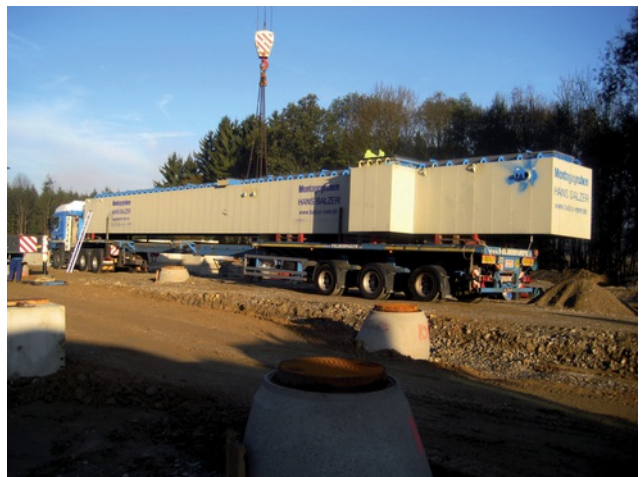
Versetzen Prüfgrube Bild: PORR
