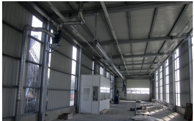
Prüfhalle Bild: PORR
