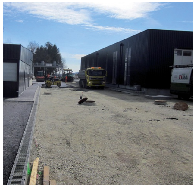
Asphaltierungsarbeiten Bild: PORR
