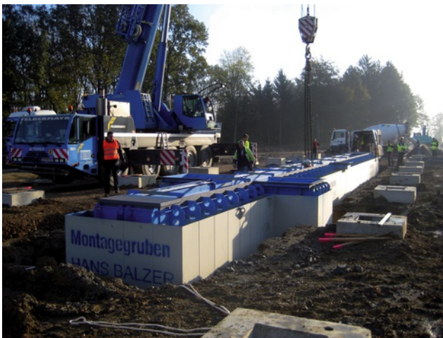
Versetzen Prüfgrube Bild: PORR
