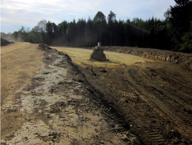
Bodenverbesserung Bild: PORR
