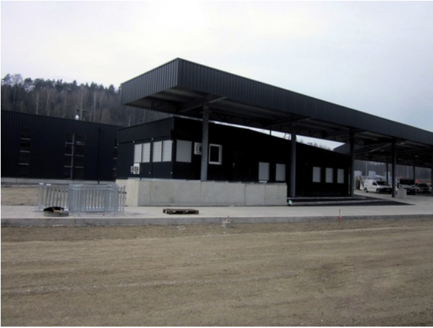
Betriebsgebäude mit Flugdach Bild: PORR
