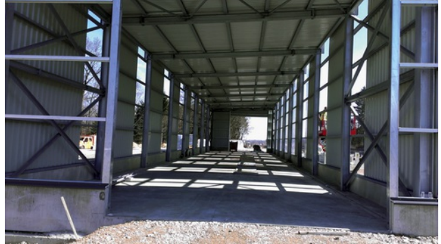
Prüfhalle Bild: PORR
