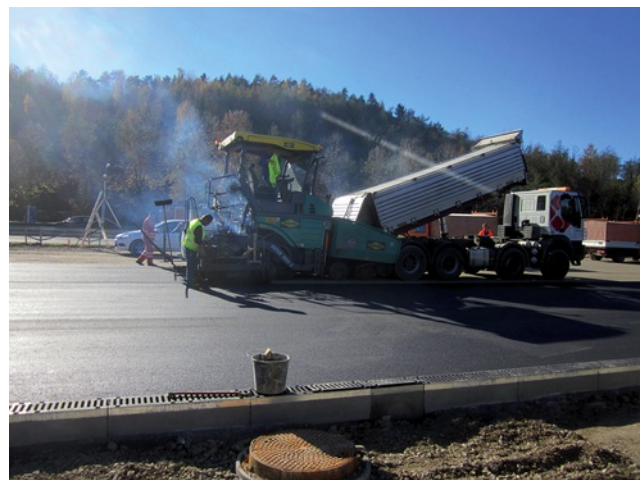
Asphaltierung Bild: PORR
