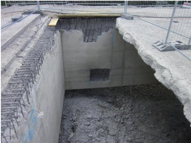
Abtragsarbeiten, Vorbereitung Vorspannungsmaßnahmen, P44 Widerlager Graz
