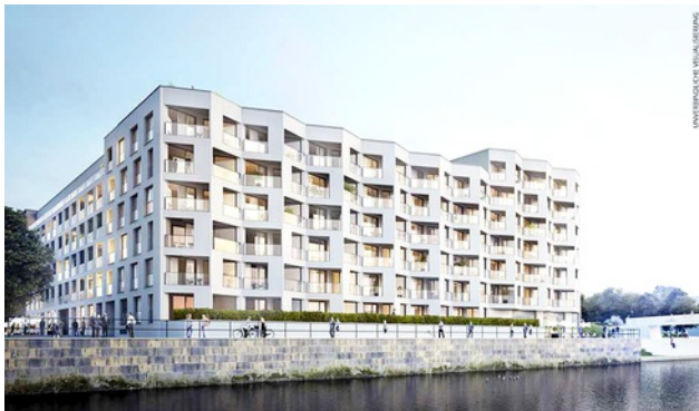
Die Fassade von THE ONE wird mit Klinkerriemchen, Weißbetonfertigteilen und Fertigteilbalkonen aufwändig gestaltet. Bild: BUWOG
