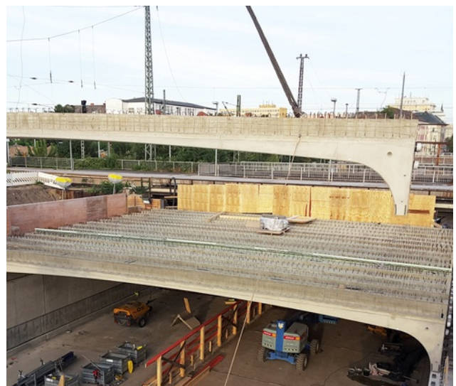
Einbau der Spannbetonfertigteile. Bild: PORR AG
