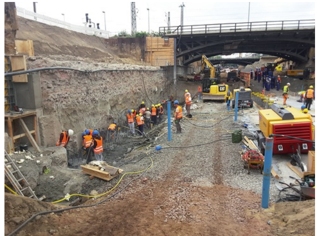
Oft waren mehrere Gewerke zur selben Zeit und am selben Ort im Einsatz. So erfolgte etwa das Abstemmen der Bohrpfähle gleichzeitig und auf engstem Raum mit dem Erdbau-, Ingenieurbau- und Wasserhaltungsarbeiten. Bild: PORR AG
