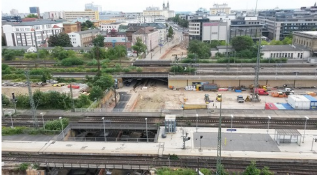
Blick von einem Turmdrehkran auf die Baustelle der Eisenbahnüberführung Ernst-Reuter-Allee. Bild: PORR AG
