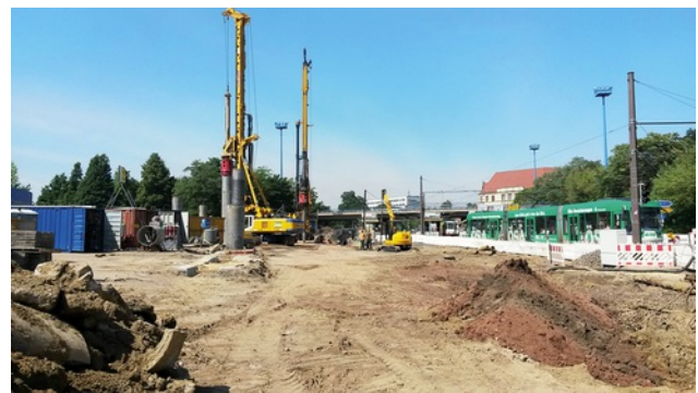
Damaskplatz mit den Bohrgeräten – BG40 und BG36H. Bild: PORR AG
