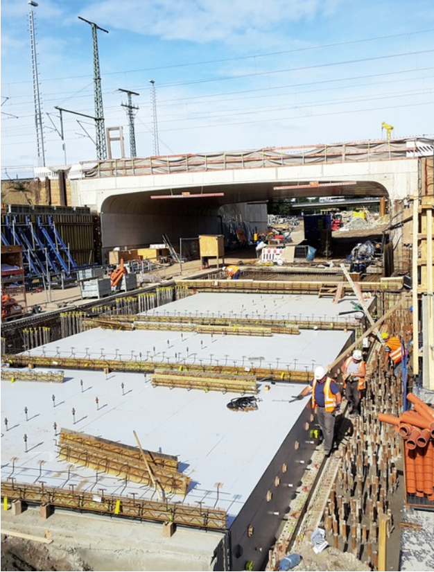
Bewehrtes Treppenhaus und die Tunneldecke Bild: PORR AG
