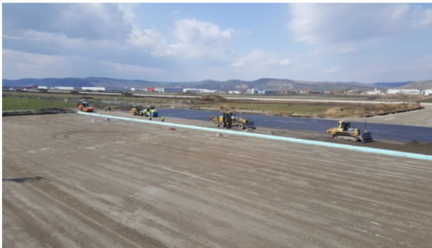
Im Herbst 2017 startete die PORR die Sanierungsarbeiten an dem 2016 wegen schlechten Zustands gesperrten Flughafen. Bild: Zi de Zi – Ligia Voro
