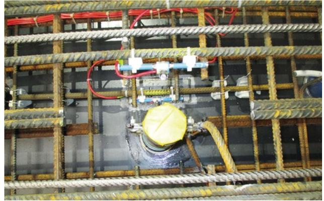
Umfangreiche messtechnische Überwachungen aller Bauabschnitte. Hier zu sehen: Messsysteme im Tübbing zur Ermittlung der Auslastung.
