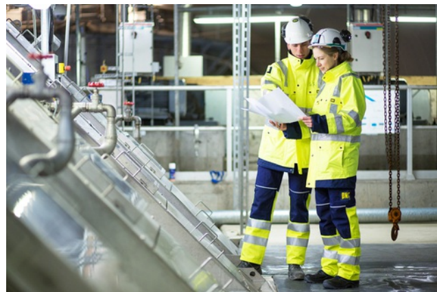
Überprüfung der bestehenden Anlage. Bild: PORR AG
