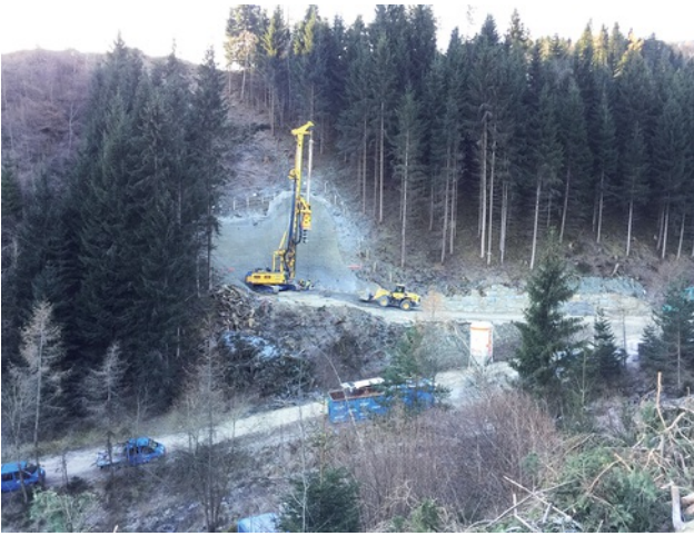
Bohrpfahlgründung Pfeiler 2 Bild: PORR AG
