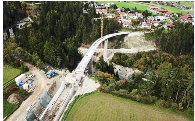
Bauzustand Brücke und Trogbauwerk im September 2017. Bild: PORR AG
