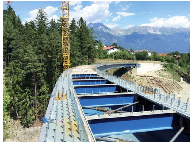
Stahltragwerk vor Herstellung der Verbundplatte. Bild: PORR AG
