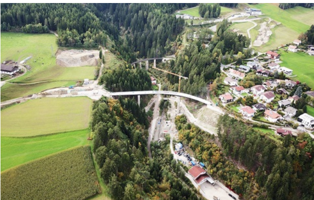
Luftaufnahme der Brückenkonstruktion kurz vor Fertigstellung in der Mitte des Bildes. Dahinter die alte Brücke, die fortan von Fußgängern und Radfahrern genutzt wird. Bild: PORR AG
