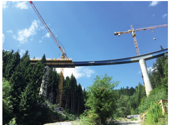
Herstellung der Verbundplatte des Brückentragwerks. Bild: PORR AG
