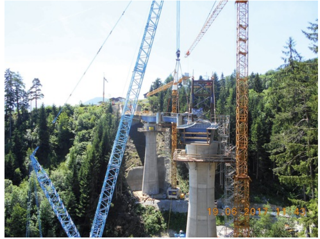
Einhub Nr. 4 mit Stahlbauschuss 6 und 7 mit 63 t. Bild: PORR AG
