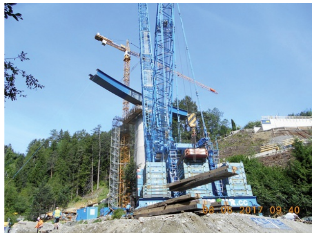
Einhub Nr. 3 mit Stahlbauschuss 3,4 und 5 für mit 182,6 t. Bild: PORR AG
