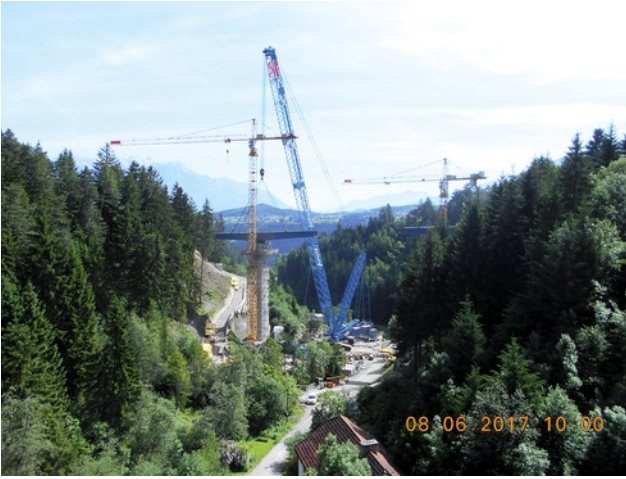
Einhub Nr. 3 Stahlbauschuss 3, 4 und 5 mit 182,6 t. Bild: PORR AG
