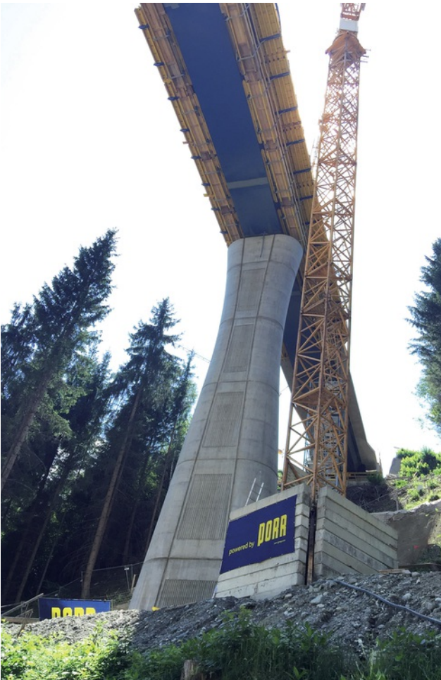
Herstellung der Verbundplatte des Brückentragwerks. Bild: PORR AG
