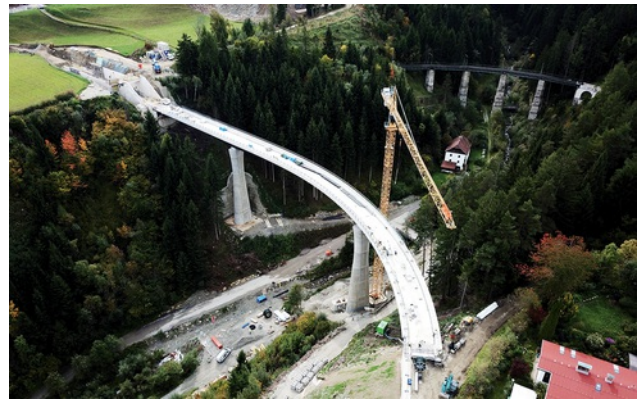
Bauzustand Brücke und Trogbauwerk im September 2017. Bild: PORR AG
