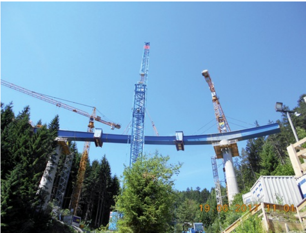
Einhub Nr. 4 mit Stahlbauschuss 6 und 7 mit 63 t. Die Montage der Stahlschüsse erfolgte mit Hilfe eines 100 m hohen Gittermastkrans. Bild: PORR AG
