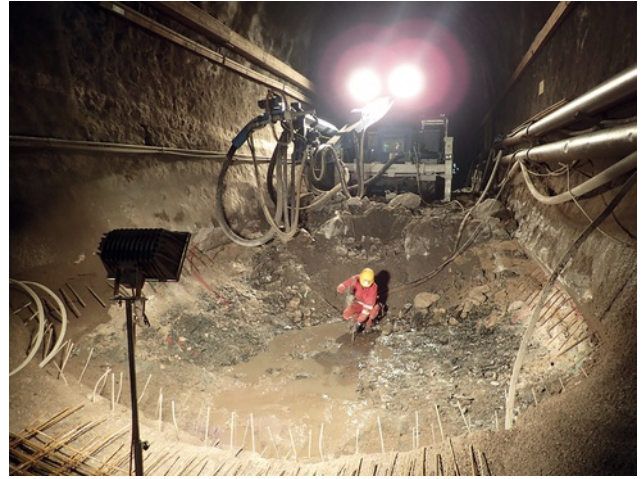
Sohlabschnitt vor SpC Bild: PORR AG
