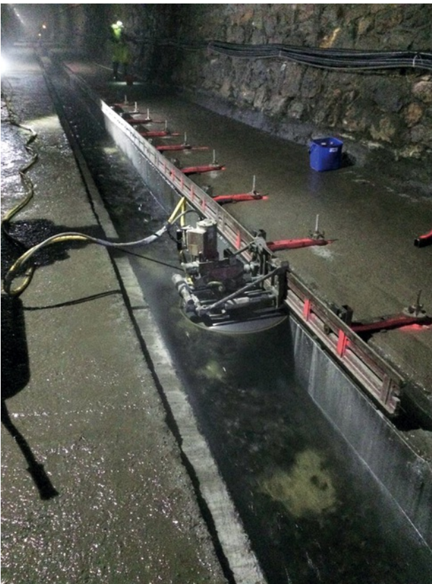
Auflager schneiden Bild: PORR AG
