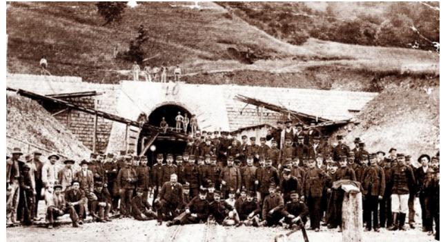
Baumanschaft 1904 Bild: PORR AG
