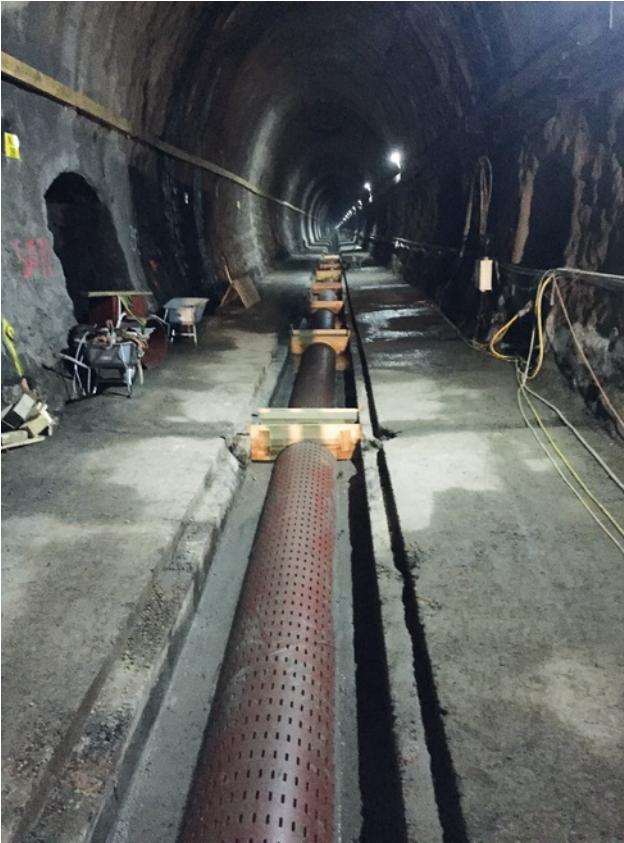
Verrohrung Sohlkanal Bild: PORR AG
