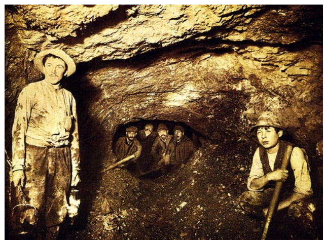
Bosruck Durchschlag Bild: PORR AG
