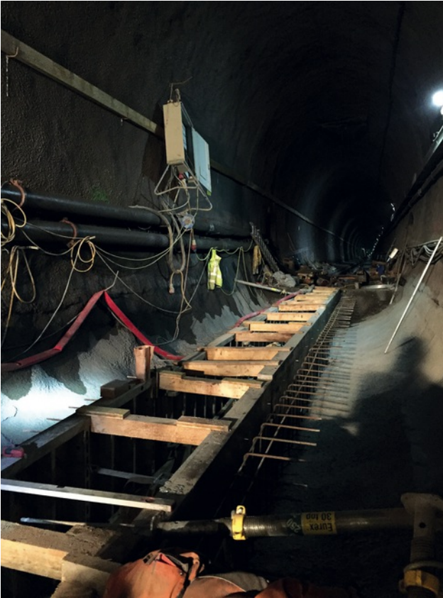
Schalung Mittelkanal Bild: PORR AG
