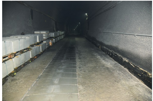
Fertige Tunnelsohle Bild: PORR AG
