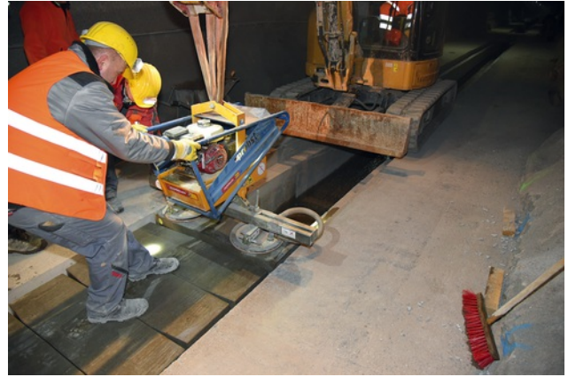
Deckel versetzen Bild: PORR AG
