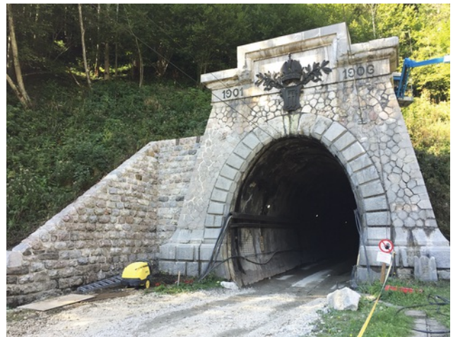
Tunnelportal Nord Sanierung Bild: PORR AG
